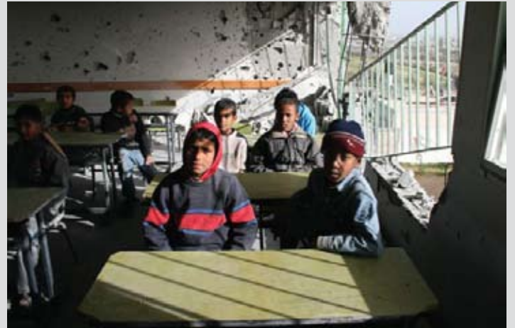
طلاب من الصف السادس في مدرسة غسان كنفاني في مدينة رفح، جنوب قطاع غزة يجلسون في فصل دراسي مدمر جزئياً. هذه المدرسة هي واحدة من أكثر من 280 مدرسة تضررت خلال الحرب على غزة في الفترة ما بين ديسمبر 2008 إلى يناير 2009. تصوير / أسامة دامو
