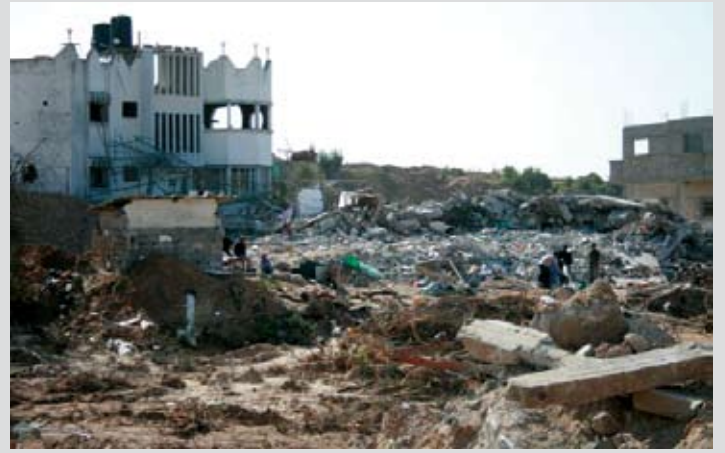
أحد المنازل المدمرة تدميراً كلياً في عزة عبد ربه، شمال قطاع غزة، والتي تضررت بشكل كبير خلال الهجوم العسكري الإسرائيلي في الفترة ما بين ديسمبر 2008 إلى يناير 2009. تصوير / أسامة دامو
